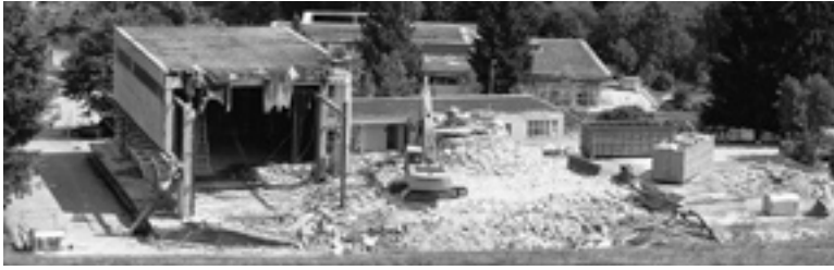
Das Abbruchvolumen beträgt 6500 m 3 .
