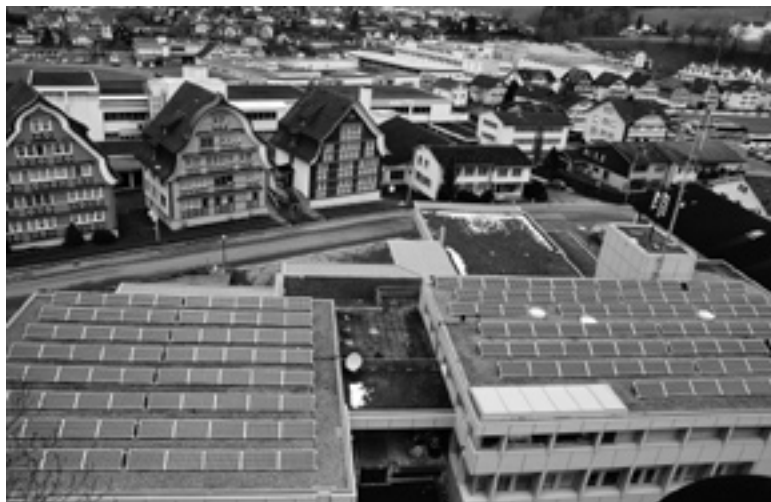
Photovoltaik-Anlage auf dem Dach des Betriebsgebäudes der Feuerschaugemeinde Appenzell.
