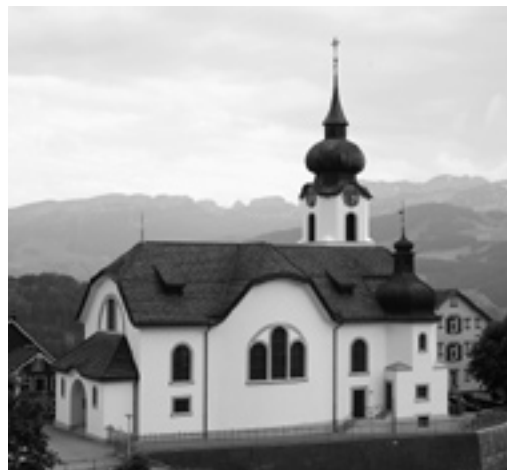
Kirche Schlatt nach erfolgter Aussenrenovierung durch die architekten:rlc ag, Rheineck.
