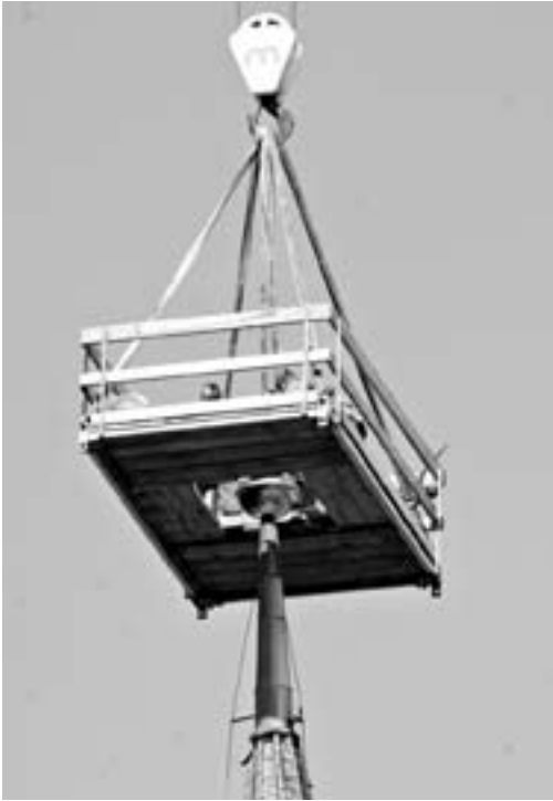
Spektakulärer Akt: Mit einem Kran holte man bei der Kirche den Turmschmuck herunter. (Bild: zVg.)
