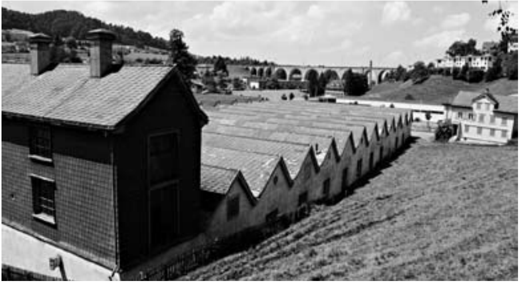
Aldi im Hintergrund ist auf dem Areal der AG Cilander bereits ansässig, doch jetzt kommt auch der zweite deutsche Discounter, Lidl, nach Herisau. Hierzu muss das ehemalige Werk 3 der Cilander mit dem Scheddach abgebrochen werden.
