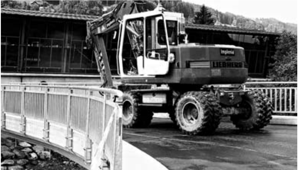
Die Brücke über den Rotbach, mit deren Bau einiges Ungemach verbunden gewesen war, konnte im Juni dem Verkehr übergeben werden.
