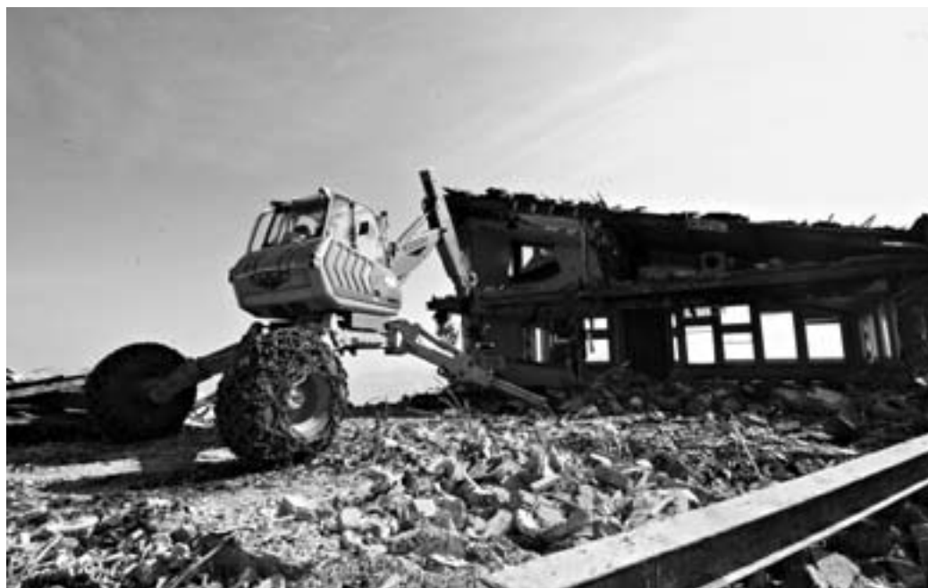
Rückbau des Bergrestaurants auf dem Hohen Kasten.
