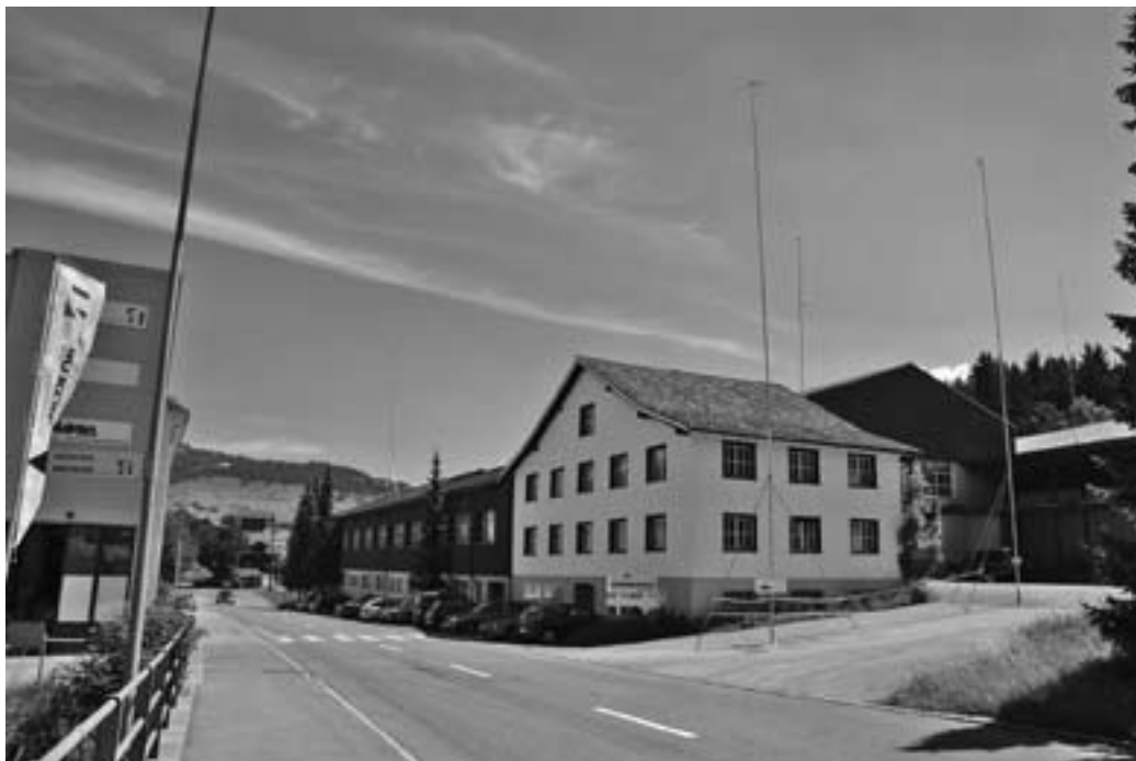
Das Bild ist bereits Geschichte. Noch stehen hier auf der ehemaligen Liegenschaft der Bodenmann Holzbau AG die Visiere für den Neubau der Arcolor. Baubeginn war 2006; der 35-Mio.-Bau ist inzwischen erstellt. (Bild: zVg.)
