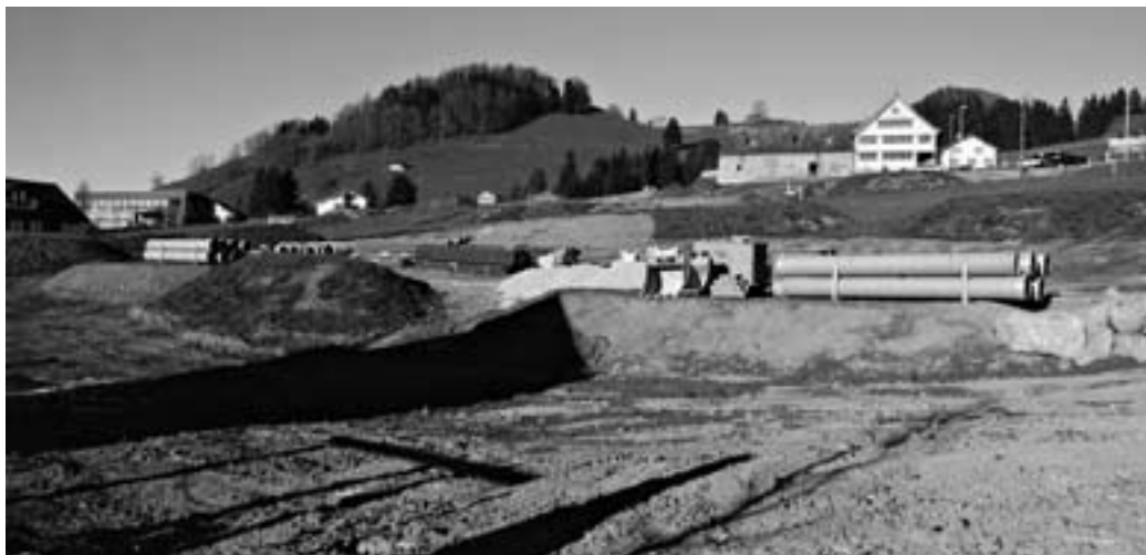
Überbauung der Liegenschaft Schönenbüel-Lehn.
