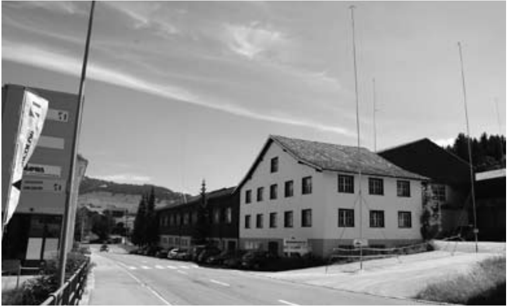
Im Herbst begann die Arcolor AG mit dem Abbruch der von ihr erworbenen Liegenschaft Holzbau Bodenmann. Gegenüber dem jetzigen Standort entsteht ein Bau mit einem Investitionsvolumen von über 30 Mio. Franken. Die Bauarbeiten haben inzwischen begonnen. (Bild: zVg.)
