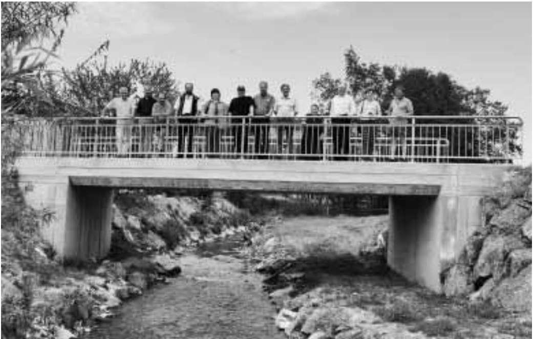
Brückeneinweihung in Schönengrund: Der Übergang «Tüfi» wurde neu erstellt.
