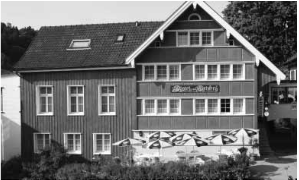
Das Hotel-Restaurant «Ochsen» nach der sanften Renovation.
