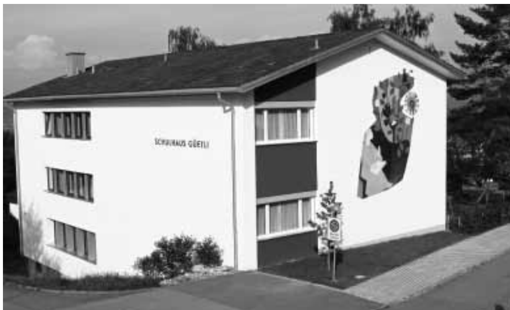
Das Schulhaus Gütli wurde renoviert.
