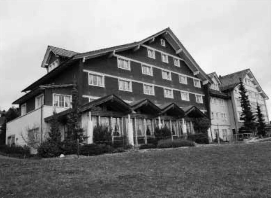
In zehnmönatiger Umbauzeit wurde das Altersheim Rotenwies auf den neuesten Stand gebracht. (Bild: Hans Hürlemann)
