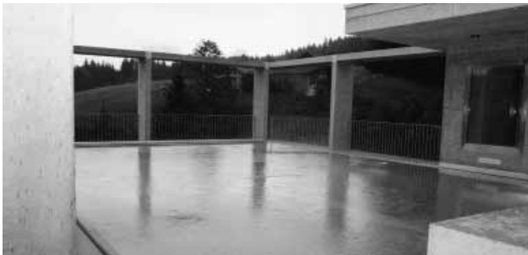
Die erste Etappe zum Vorderländer Gesundheits- und Wellnesspark ist erfolgreich beendet. Das Heilbad Unterrechstein verfügt neu über ein beheiztes Aussenbad.
